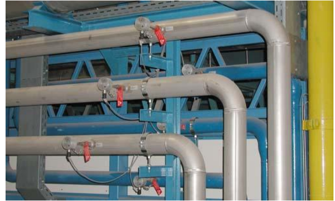
空气输入管道 装有Schmidt传感器 SS 20.60
