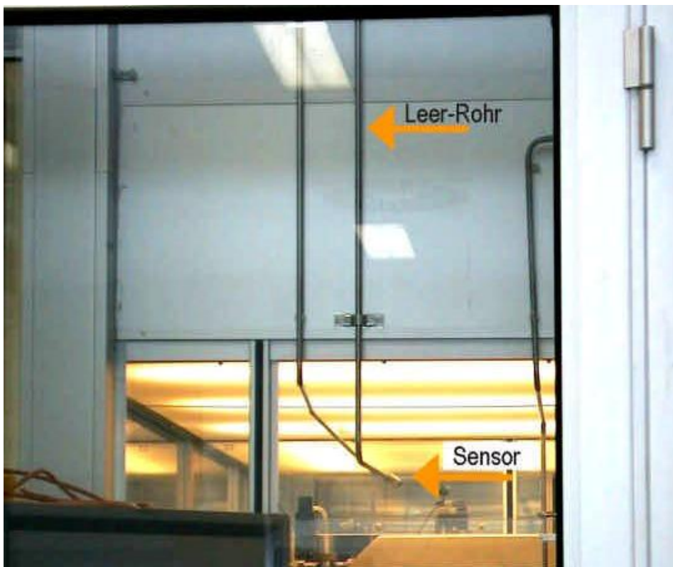
特殊情况在灌装生产线 低位安装 Flow-Box .
